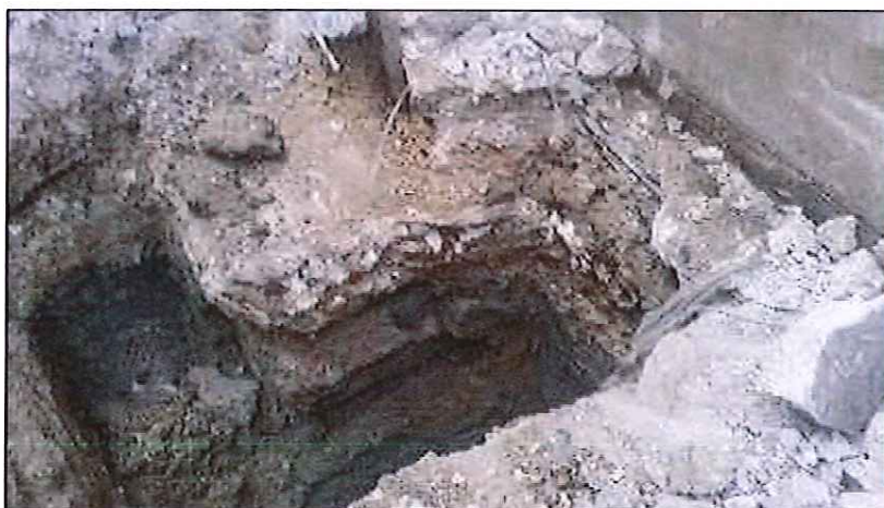
Foto n. 1: trincea esplorativa T. E. 1
