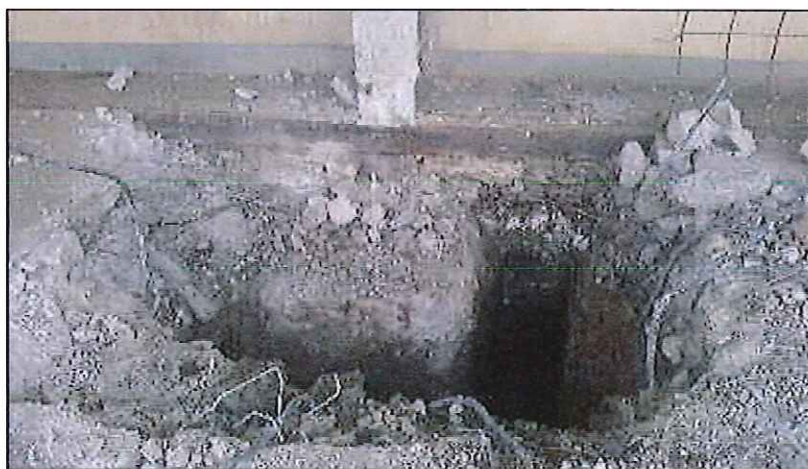
Foto n. 3: trincea esplorativa T. E. 2
