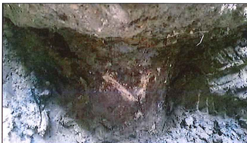
Foto n. 3: palo di fondazione trincea esplorativa T. E. 1
